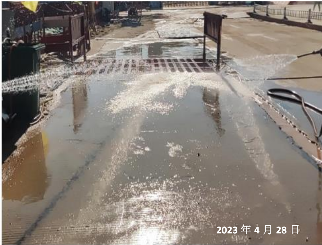
（施工出入口硬化及洗车池）
