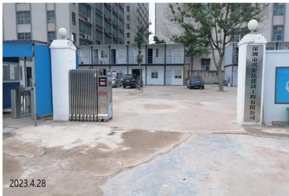
附件 6：水土保持工程施工过程照片
