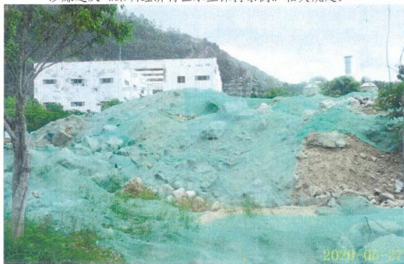
图 2. 项目临时堆土防护措施不足，存在水土流失隐患。
