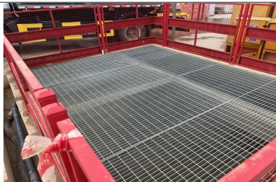
现状洗车池侧沉砂池
