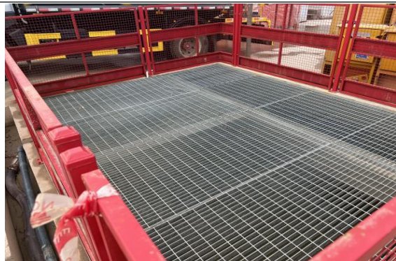
现状洗车池侧沉砂池
